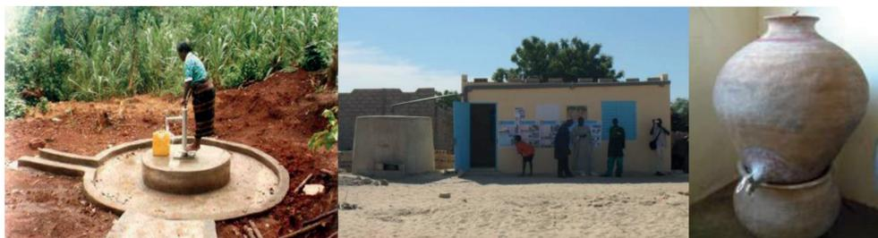
**Fig. 1** – Pozzo protetto (sx), sistema di raccolta dell'acqua piovana (centro) e serbatoio per lo stoccaggio domestico dell'acqua (dx)
