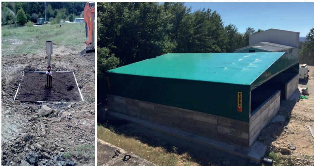
Fig. 1 – Impianti dimostrativi: Biowindows (a sinistra) e Biofiltro (a destra).
