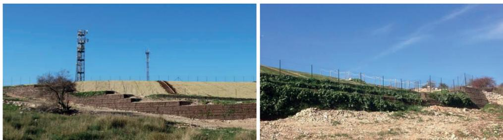
**Fig. 2** – Muro in terra armata realizzato
