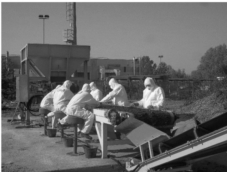
**Fig. 2** – Cernita e separazione manuale dei frammenti di eternit dal terreno mediante operatori qualificati e nastro trasportatore a supporto.
