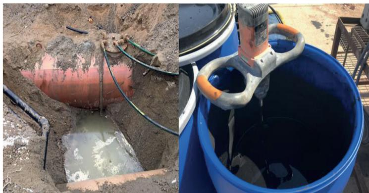
**Fig. 4** – Foto dell'intervento di bonifica. A sinistra: Area di scavo e serbatoio interrato. A destra: Attività di miscelazione del prodotto PetroFix.
