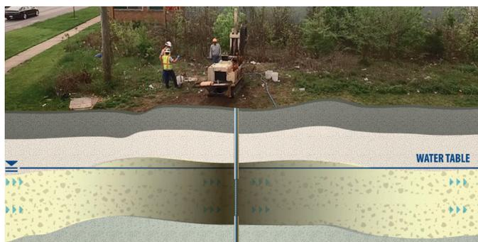
**Fig. 2** – Iniezione mediante tecnica *direct push*. Rivestimento a bassa pressione delle zone di flusso permeabili. Si noti l'utilizzo di punta di iniezione retrattile anziché la punta attivata a pressione maggiormente comune per le attività di iniezione. Tale punta retrattile consente una maggiore omogeneità di distribuzione del prodotto nel sottosuolo.
