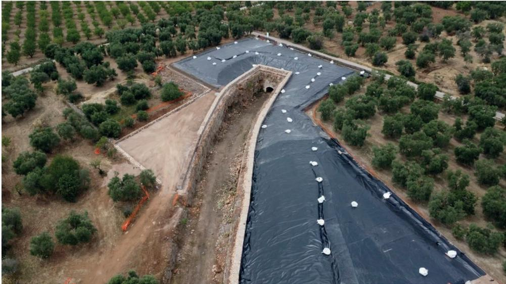
**Fig. 4 –** *Avvio della fase di copertura dell'ex discarica dopo modellazione superficiale (impresa esecutrice Fedele Di Donato srl)*
